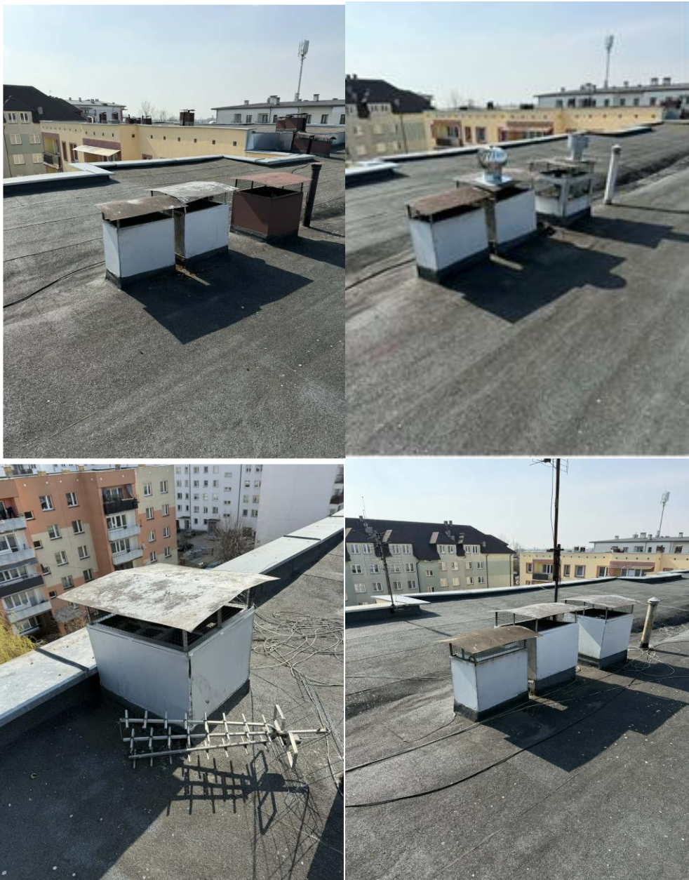
Zdjęcia istniejących kominów do remontu
