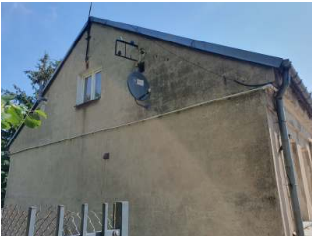
Zdjęcie 2 – szczyt od strony zachodniej – widok ogólny
