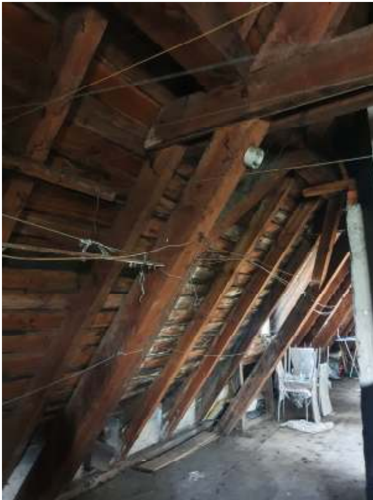
Zdjęcie 6 - widok ogólny na układ elementów więźby- widoczne zawilgocenie poszycie z desek
