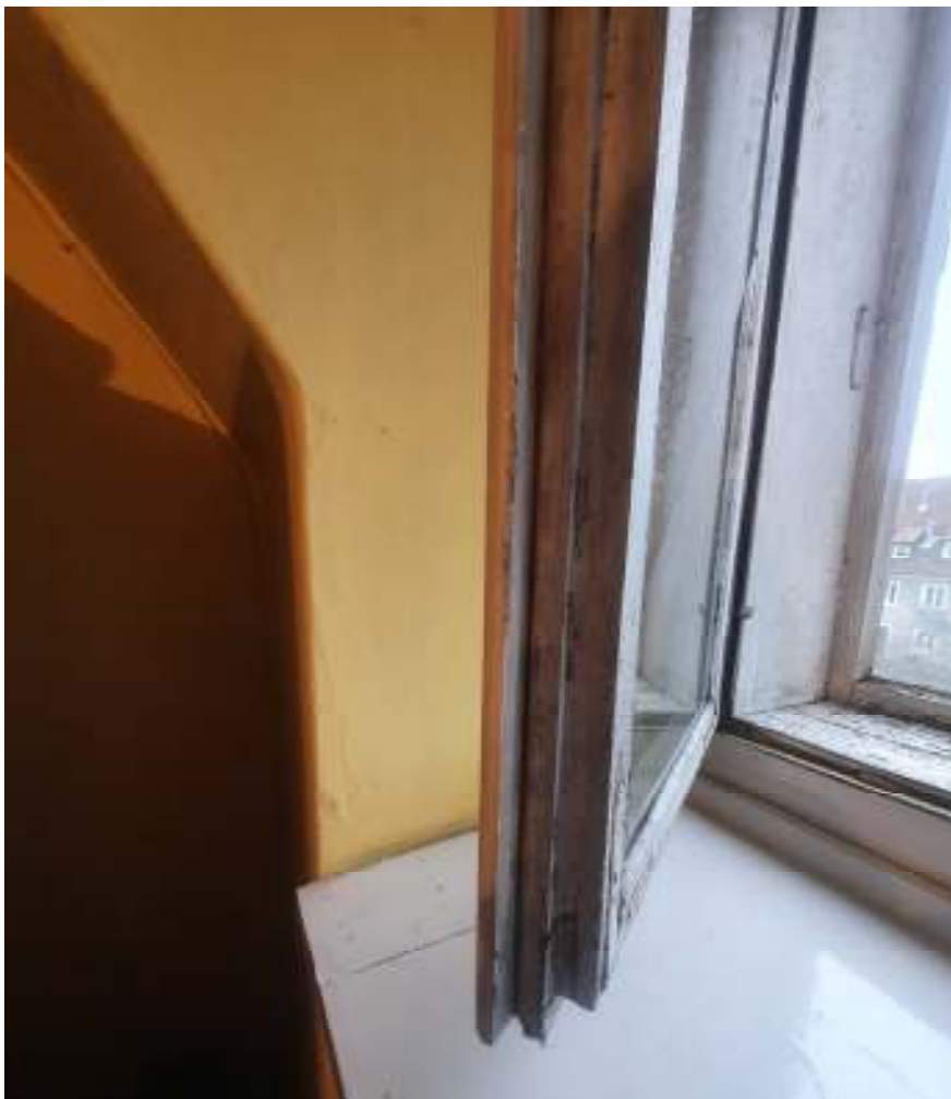
Zdjęcie 8 – widok skrzydła wewnętrznego
