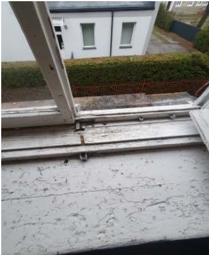
Zdjęcie 3 – Okno na klatce – widok parapetu zewnętrznego i wewnętrznego
