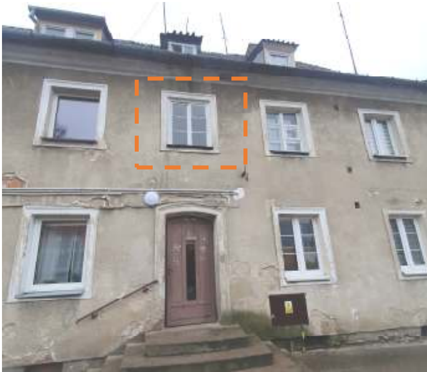
Zdjęcie 1 – Okno pomiędzy lokalami 17 i 18 – stan istniejący – widok z zewnątrz
