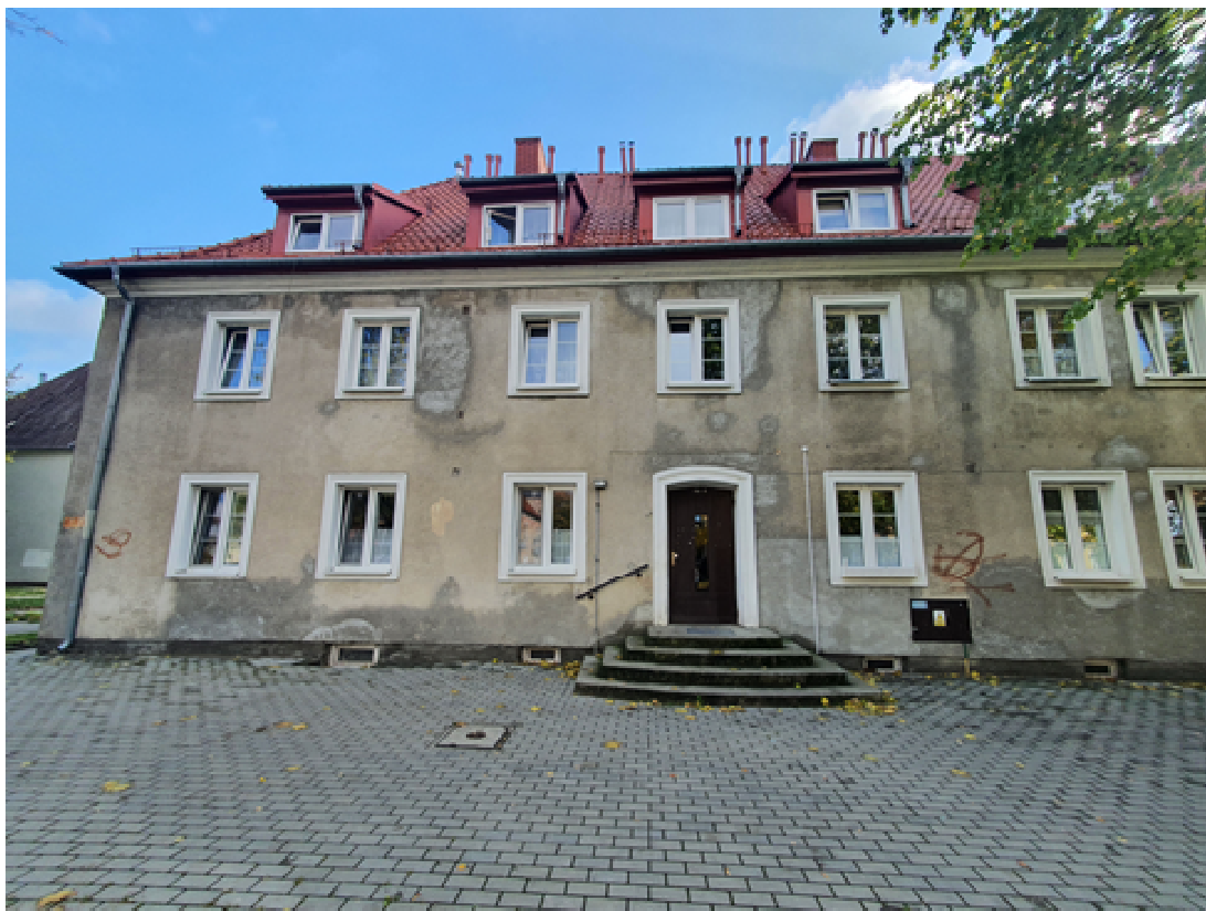
Zdjęcie 1 - Widok ogólny elewacji
