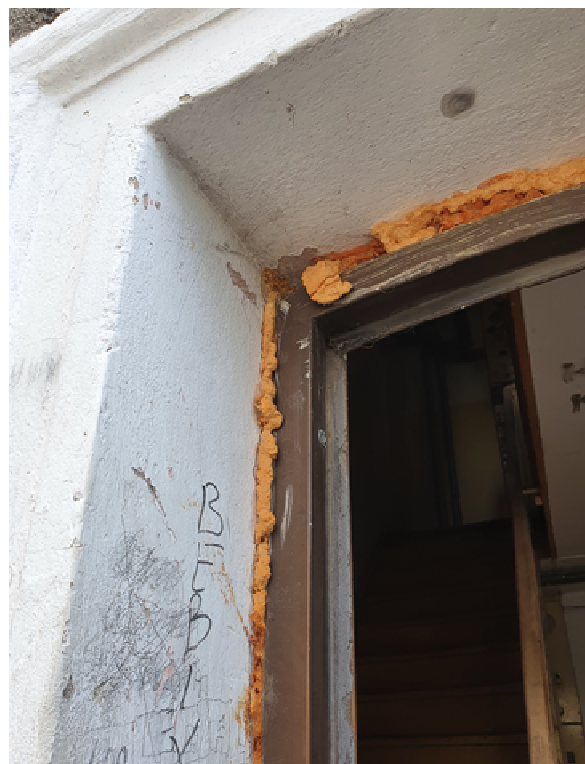
Zdjęcie 3 - Szczegół zamocowania istniejącej ościeżnicy
