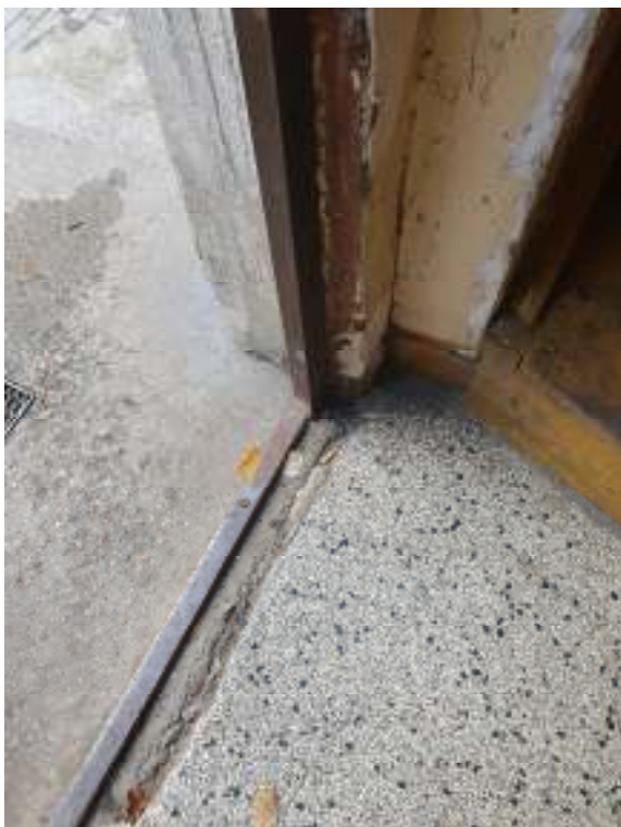
Zdjęcie 4 - Istniejący próg stalowy
