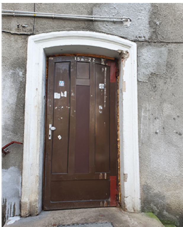
Zdjęcie 2 – Istniejące drzwi PVC
