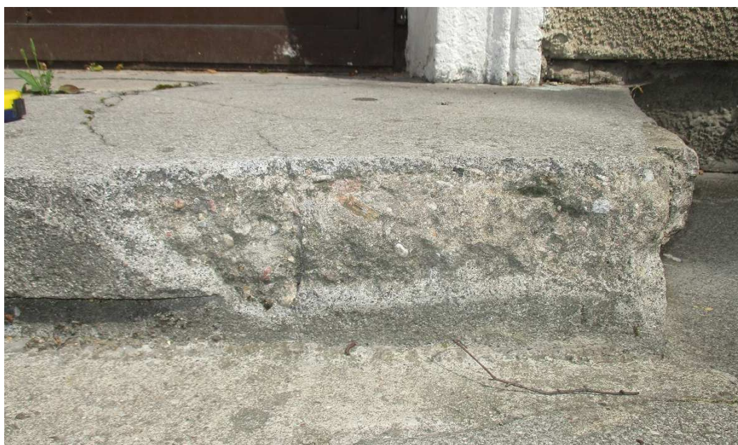
Foto 2. Schody tylne widoczna wierzchnia warstwa z lastryko płukanego
