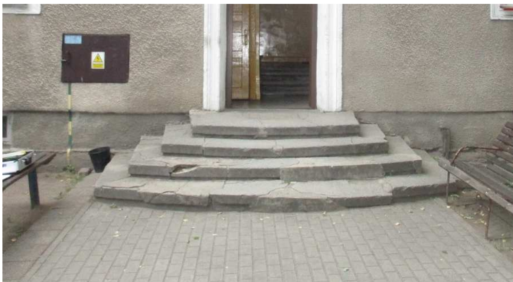
Foto 3. Schody wejściowe do klatki 1 z licznymi ubytkami i uzupełnieniami
