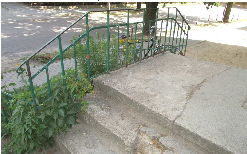
Foto 11. Schody wejściowe do klatki 5 – widoczna dolana część schodów zmieniająca geometrię
