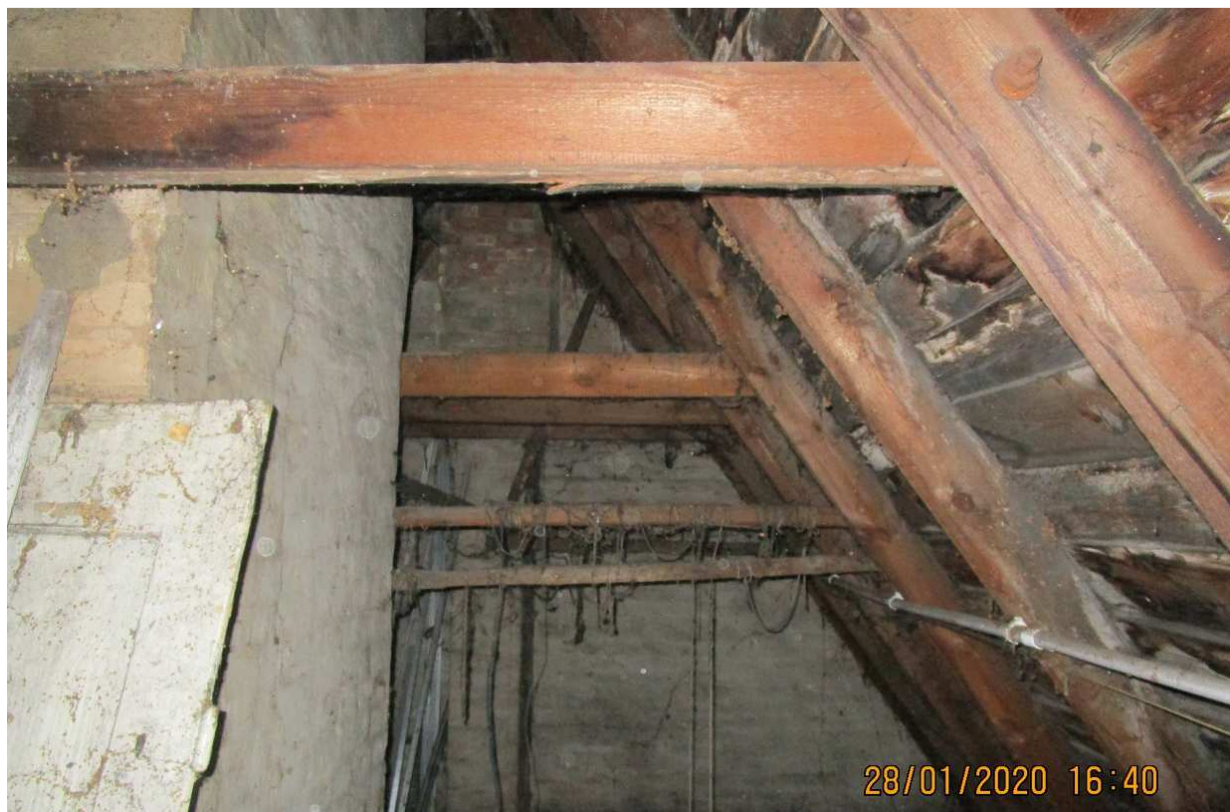
Foto 16 Rozwiązanie konstrukcyjne więźby dachowej
