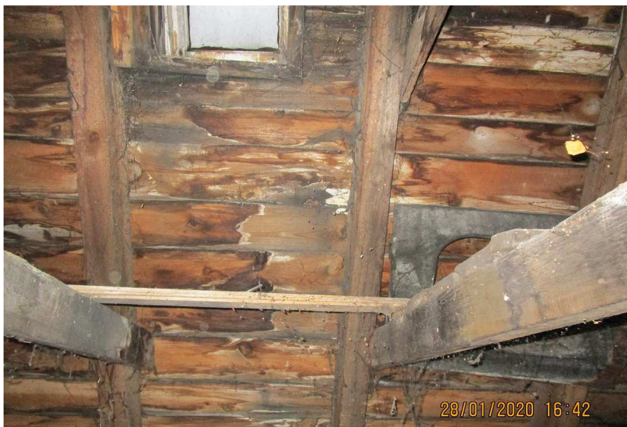
Foto 17 Ślady zagrzybienia deskowania przy kominie spowodowane nieszczelnością pokrycia dachowego i zaciekaniami wód opadowych.
