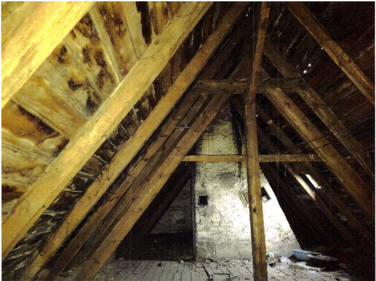
Drewniana konstrukcja dachu.
