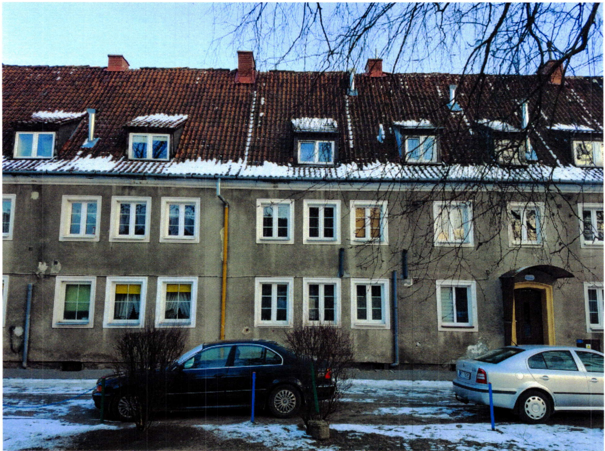
Fragment elewacji frontowej ( wejście do budynku)
