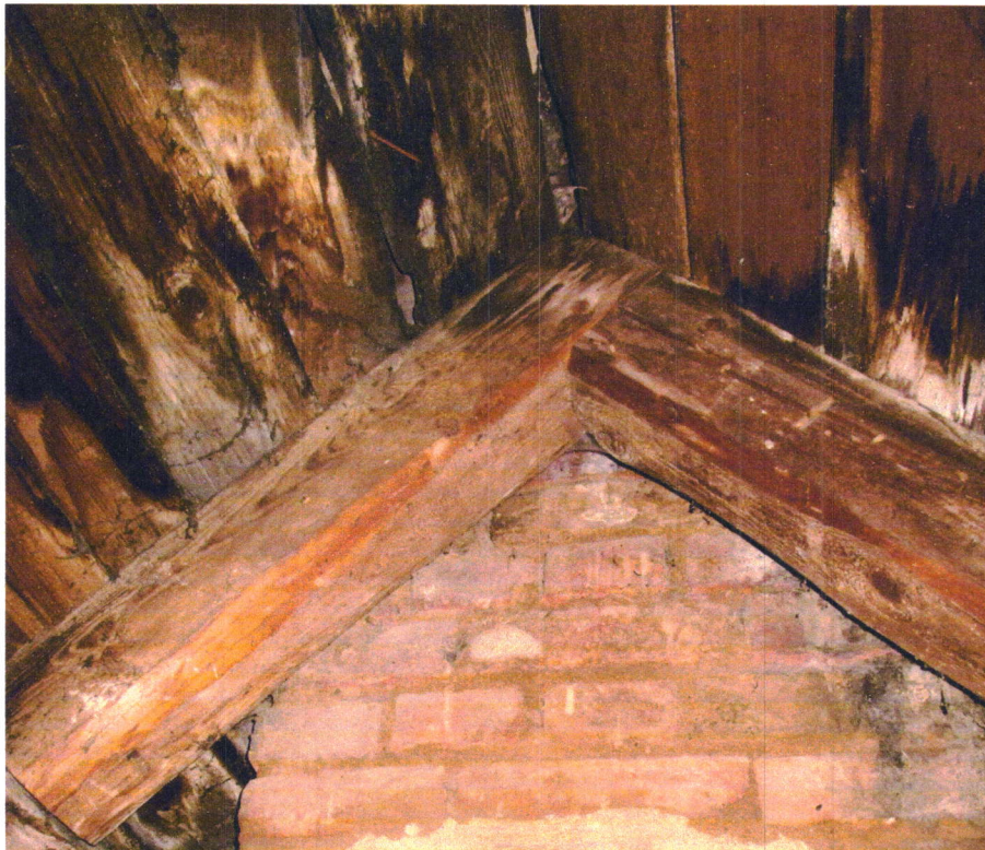
Foto 17 Ślady zagrzybienia deskowania przy kominie spowodowane nieszczelnością pokrycia dachowego i zaciekaniem wód opadowych.
