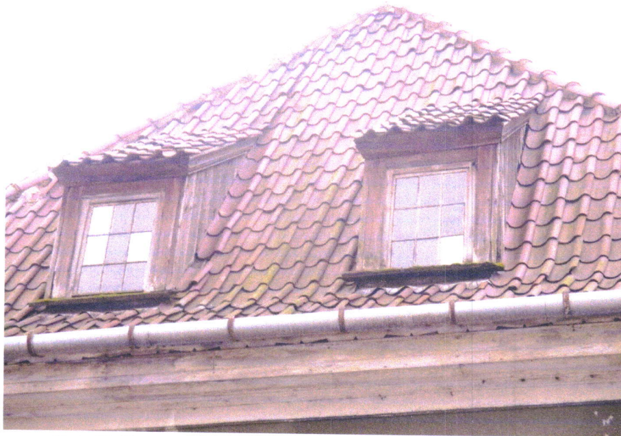
Foto 18 Obecne pokrycie dachu z dachówki typu S. Widoczne lukarny na połaci szczytowej ze starymi drewnianymi oknami
