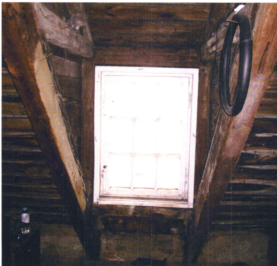
Foto 16 Rozwiązanie konstrukcyjne więźby dachowej w miejscu lukarn
