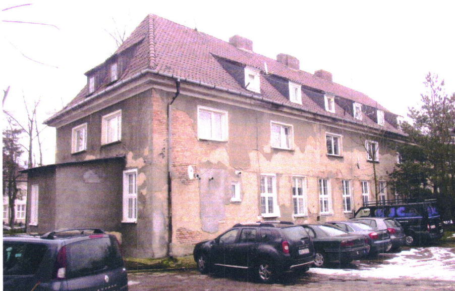
Foto 5 Ubytki w tynku
